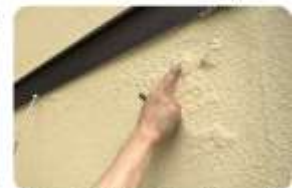
外壁の浮きやハガレをチェック。
